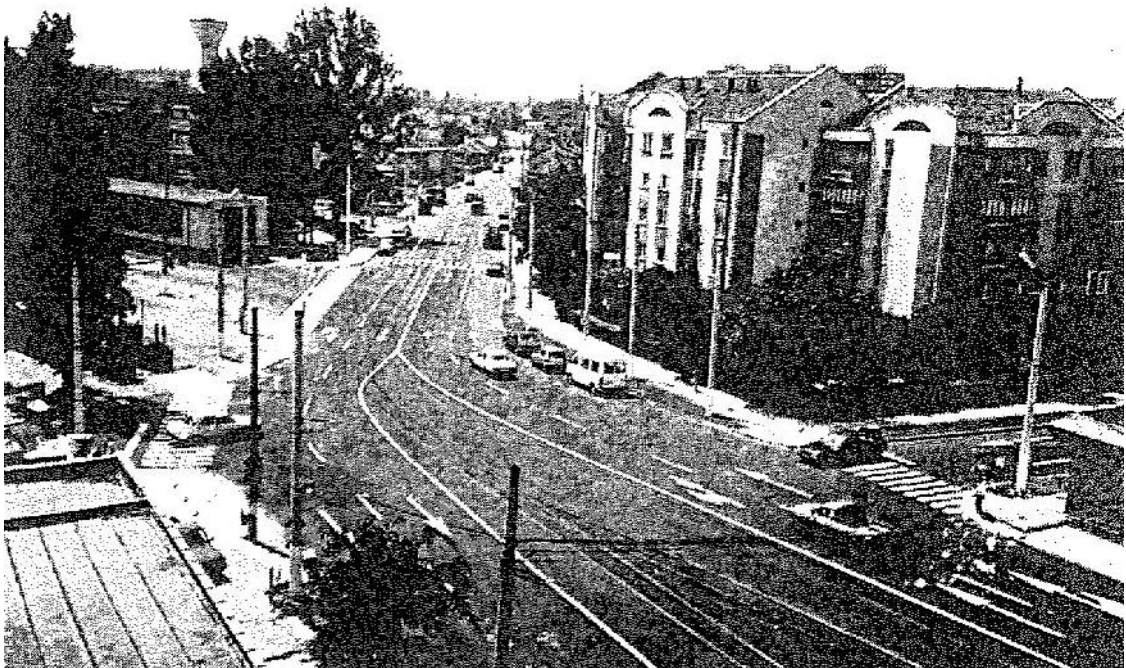
Fig. 140 – Strada Cororilor dup reabilitare
