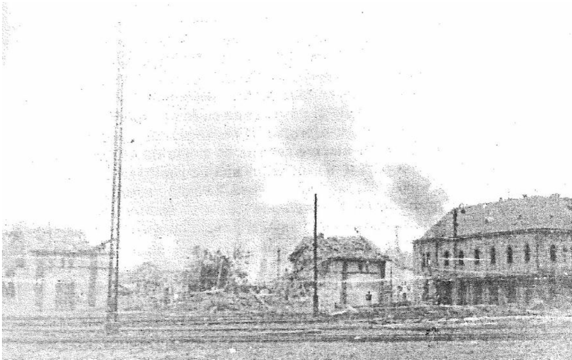
Fig. 125 – Gara CFR distrusă
