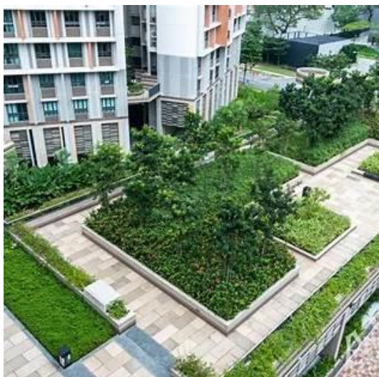
Fig.1 Acoperiș verde amplu pe clădire urbană, cu grădini amenajate și vegetație densă. Exemplu foarte bun de „green rooftop” (acoperiș verde) care servește la reducerea insulei termice, izolarea termică a clădirii și gestionarea apei pluviale. Sursa: Wikipedia
