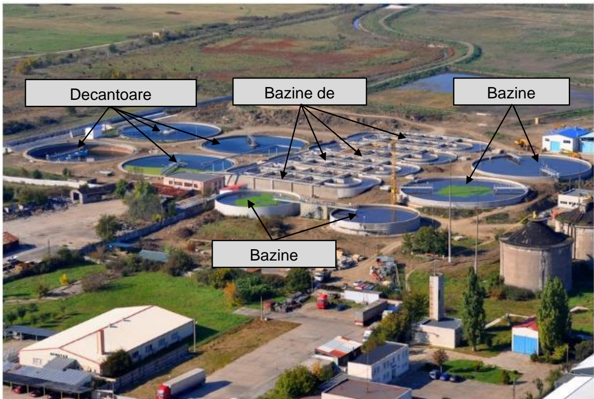
Figura 0.10. Statia de epurare Arad – vedere de ansamblu treapta biologica si bazine de retentie Sursa: Internet
