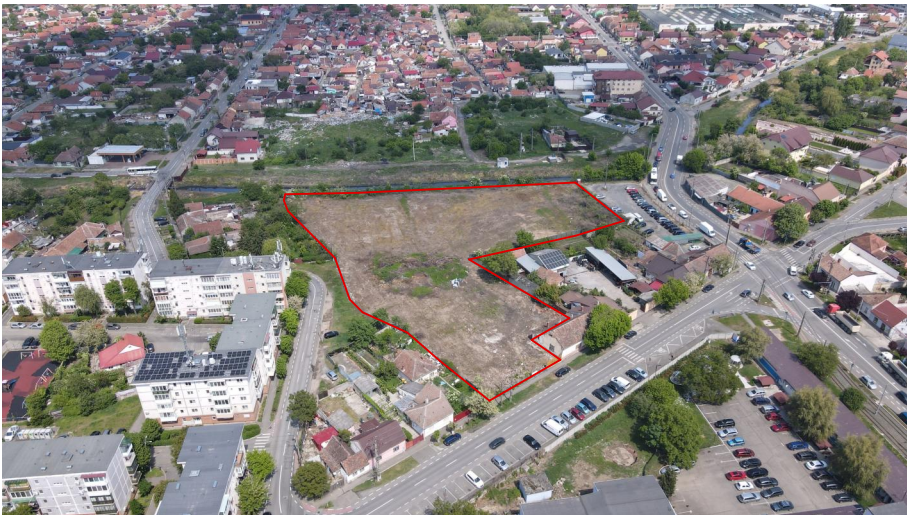
Vedere aeriană sud-vest
