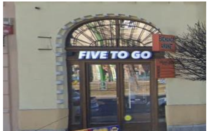
Figură 41 - Exemplu de bună practică a fațadelor comerciale - Five to Go Arad, Sursa: Google Maps
