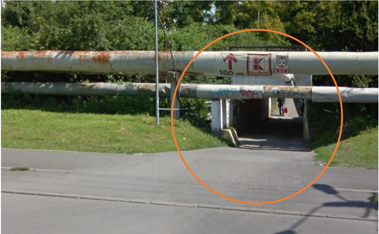
Figură 73 - Pasaj pe sub calea ferată și rețeaua de termoficare, Sursa: Google Maps, 2021
