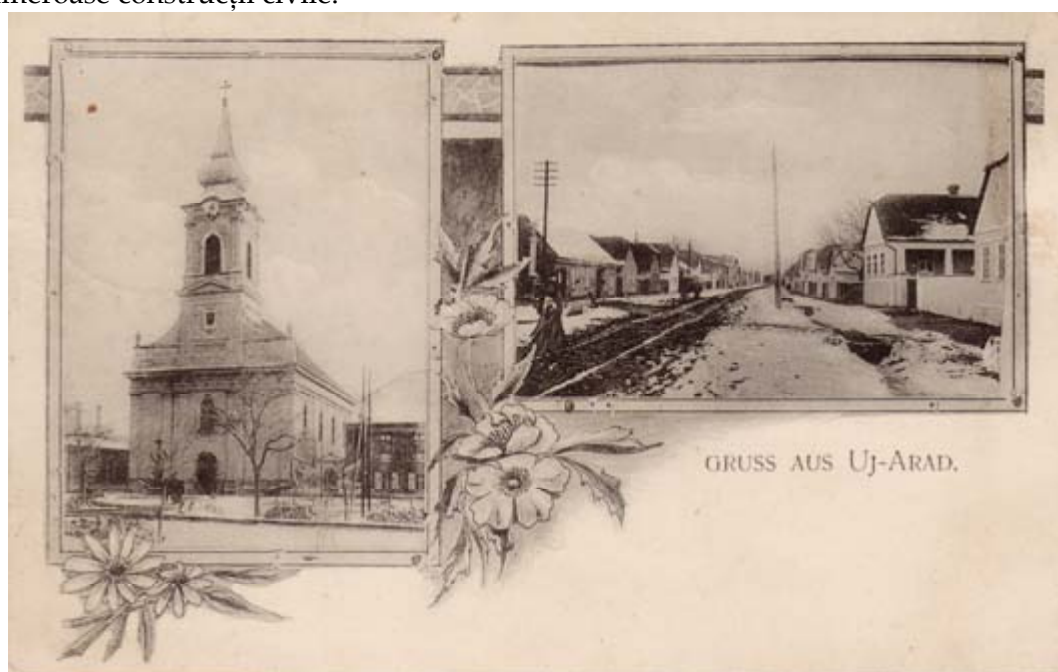
Fig. 55 Biserica Catolică din Aradul Nou și construcții civile
