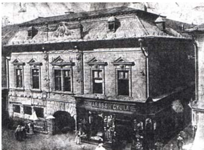
Fig. 106 Palatul Bohuș demolat
