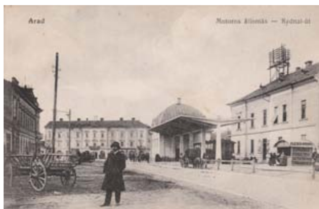
Fig. 118 Gara Electrică- demolată
