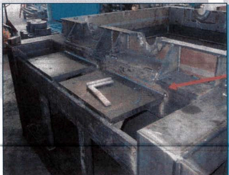
PARTE DIN CONSTRUCTIA BAZEI A DESFACATORULUI DE SACI
